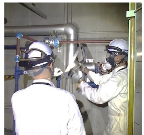
工場職員による配管改善作業
